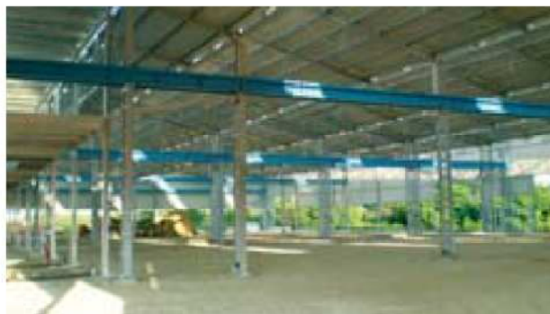
La costruzione del polo industriale di 9 mila mq
